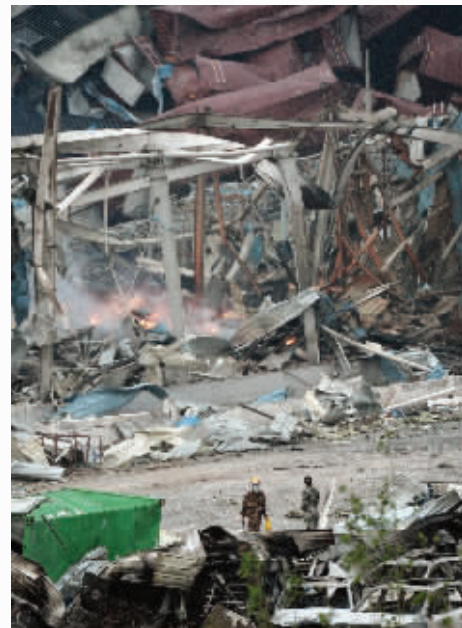
8月17日晚,爆炸事故现场仍有零星明火在燃烧,工作人员介绍这是处置过程中的正常现象。 新华社发
