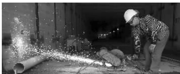
所街地下步行通道施工中 现代快报记者 徐洋 摄
