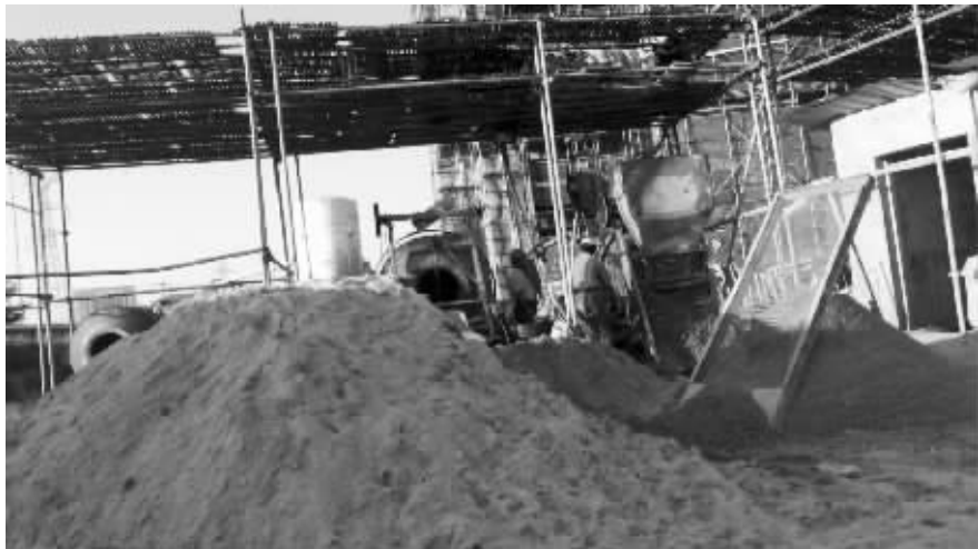
中粮鸿云坊项目工地内,工人“自拌砂浆”
