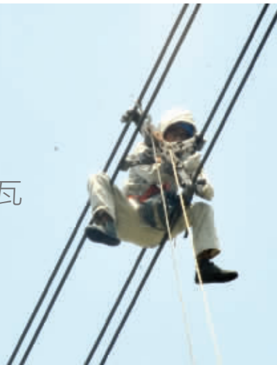
电力检修人员冒着高温在45米的高空作业 国网江苏电力供图
