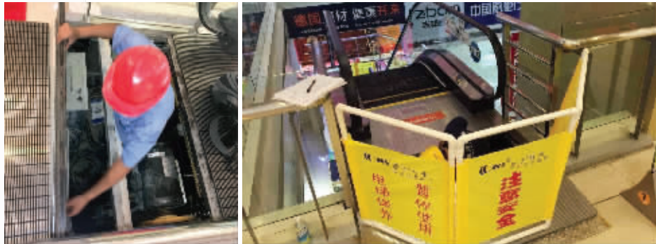
工作人员正在检查金盛国际家居各门店的电梯
