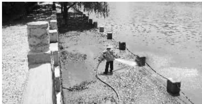
工人正在清理河岸上的淤泥
