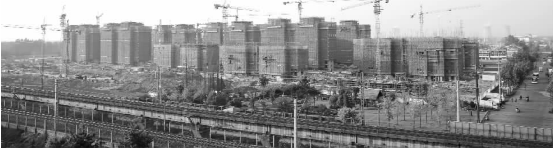
建设中的棚改安置房 通讯员 韦超 摄
