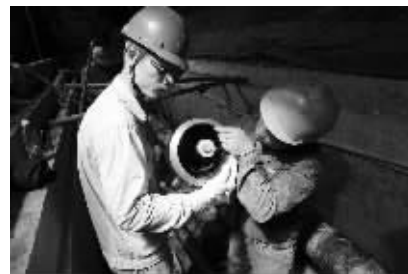
工作人员在安装电缆附件 通讯员供图
