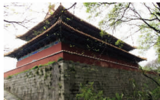
发生工人坠楼事故的明孝陵明楼 资料图片
