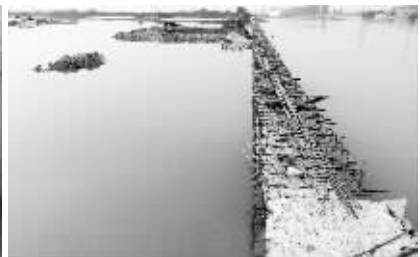
新建防洪堤现场并没有明显缺口
