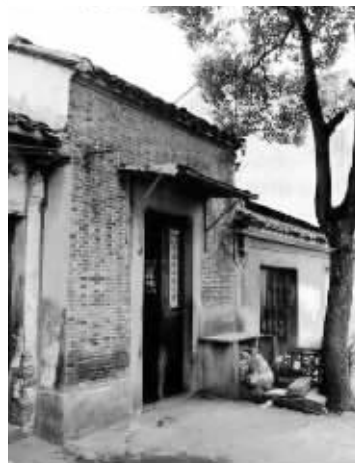
无锡荣巷内的老建筑
