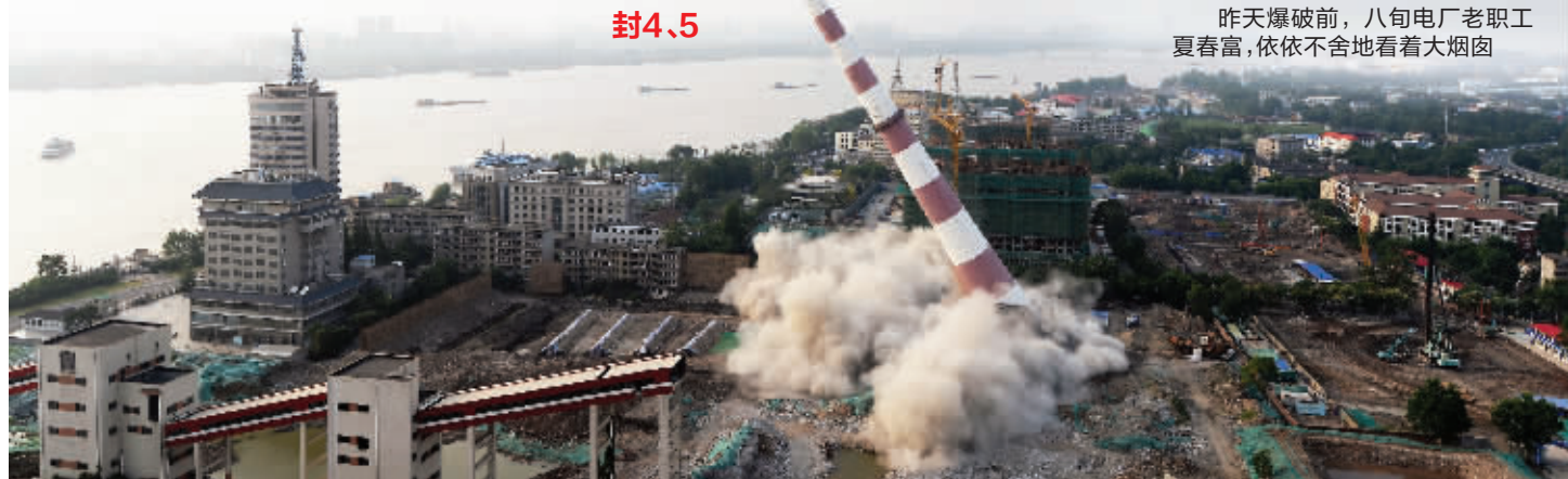
仅8秒钟,150米高的大烟囱便轰然倒下
