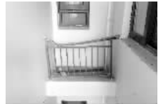
发生坠楼的天井还留有痕迹 现代快报记者 徐洋 摄
