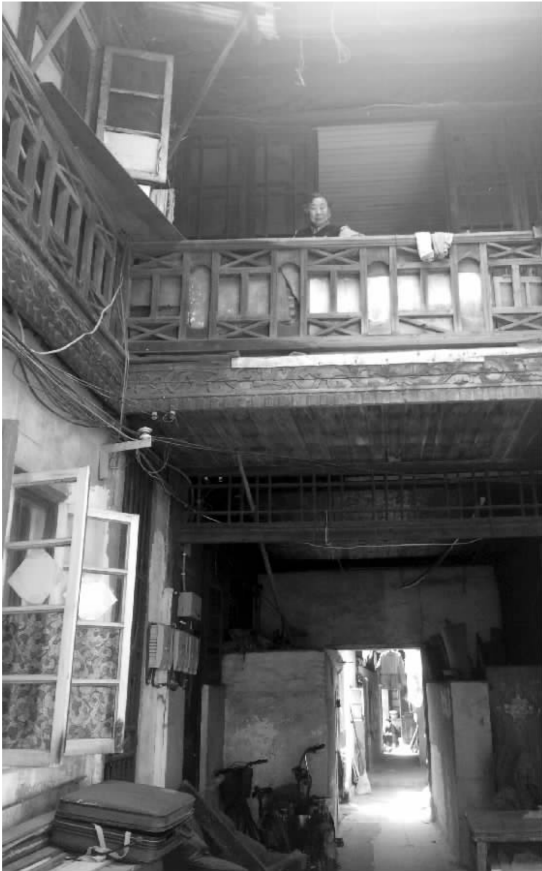
扬州不少市级文保单位内有人居住,私拉的电线裸露在外,容易引发火灾
