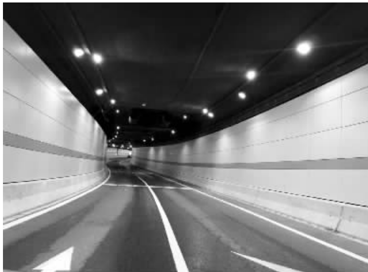
发生事故的隧道昨天已恢复正常通行 现代快报记者 李宇龙 摄
