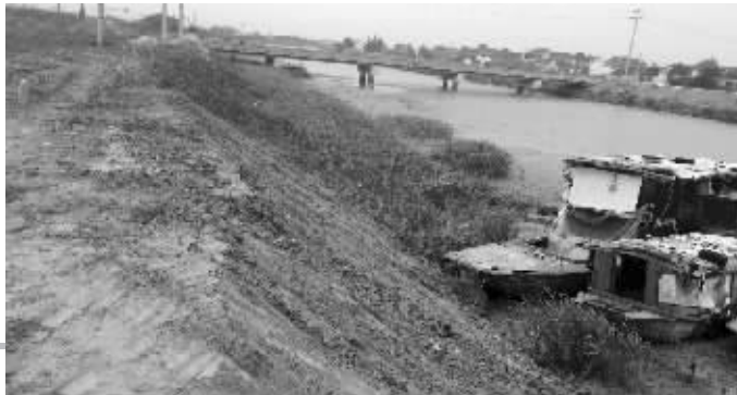
被通达建设公司占用的一段防洪堤
