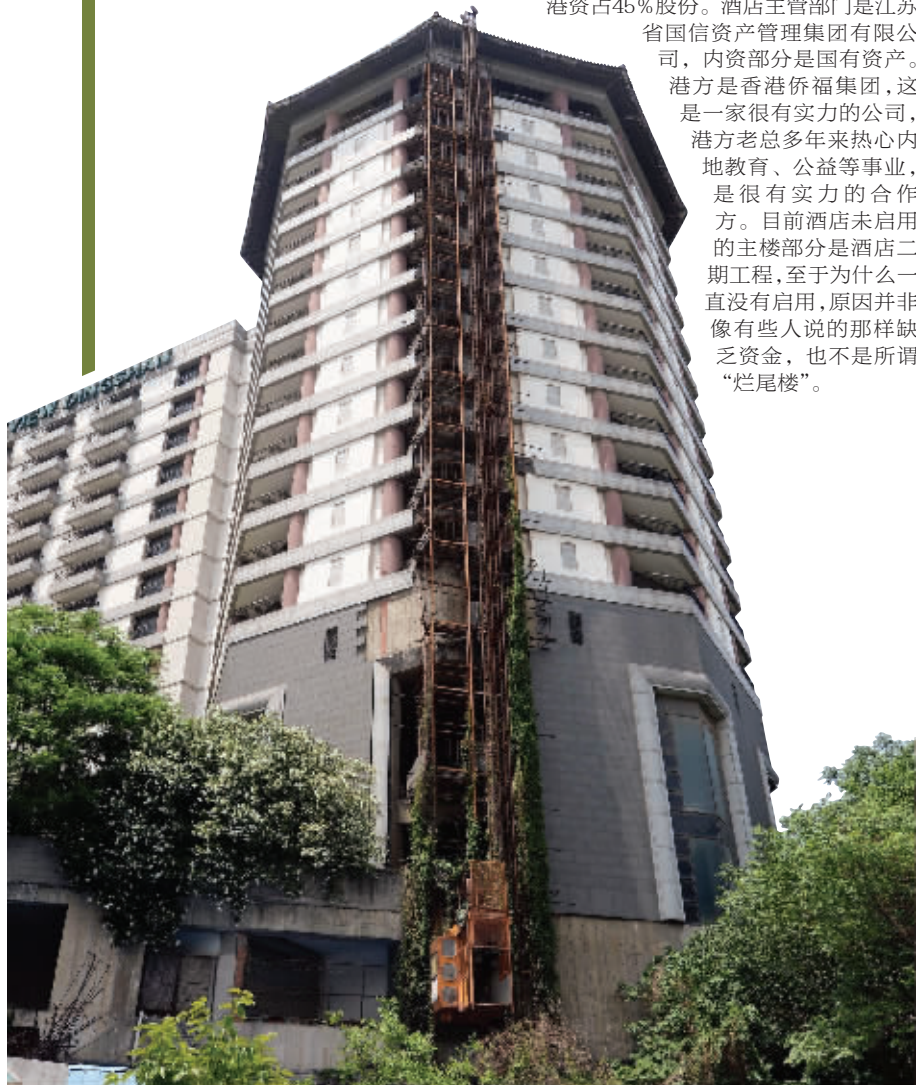
丁山花园大酒店二期工程搁浅十多年,脚手架一直未拆除
