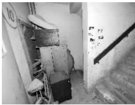
消防楼道堆满杂物
