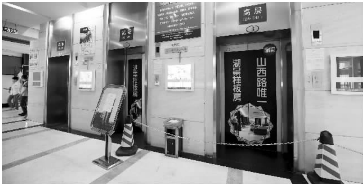
电梯已经全部停用,业主只能走楼梯回家 现代快报记者 邱稚真 摄
