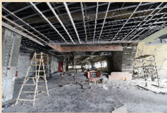
施工现场,工人在忙碌
