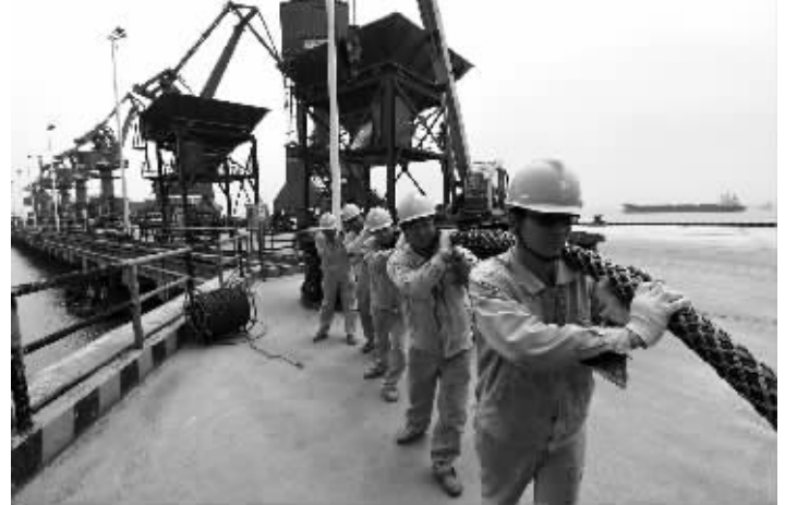
4月16号,靖江供电公司在靖江新华港务码头向船坞展放岸电系统的低压电缆。2015年,该公司将在靖江沿江的17个万吨级码头全面推广岸电系统。 新华社记者 李晓果摄
