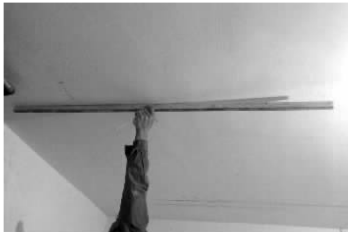
不用水平仪就能发现,天花板存在高度偏差 业主刘先生供图
