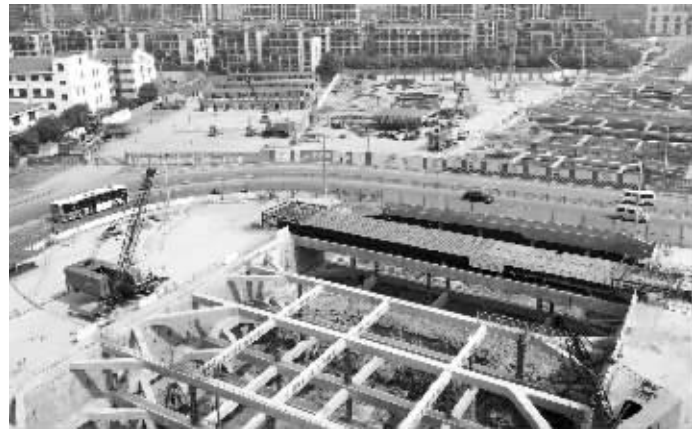
规模令人震撼的红庄站工地施工现场
