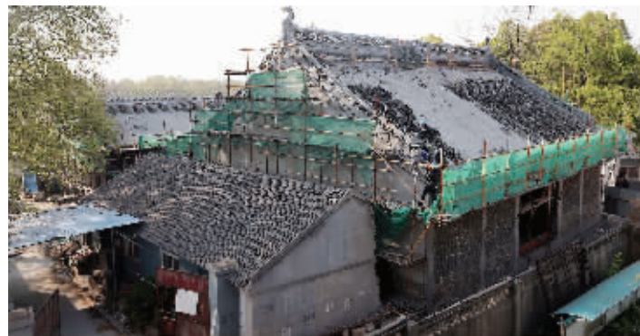
三藏殿正在进行修缮 现代快报记者 顾炜 摄
