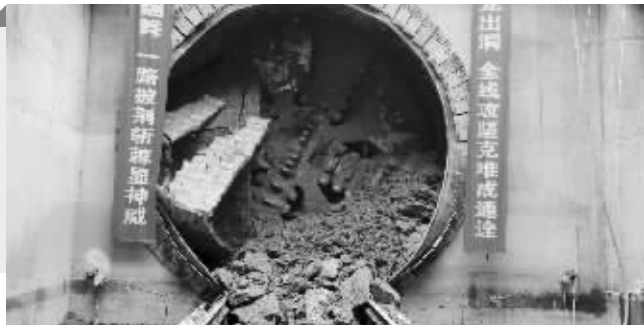
昨天上午2号线延伸线郭巷站-郭苑路区间右线顺利贯通,标志着2号线延伸线盾构施工全部完成,将进入下一个施工阶段
