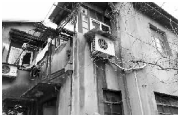
宁海路21号现状
