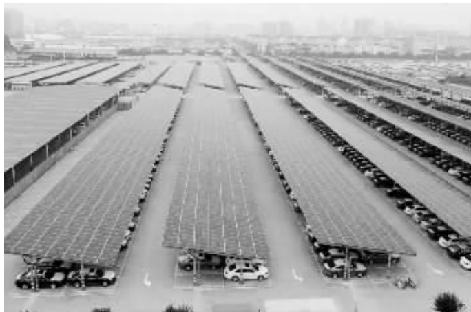
位于南京江宁的这个车棚是全球最大光伏建筑一体化电站 通讯员供图
