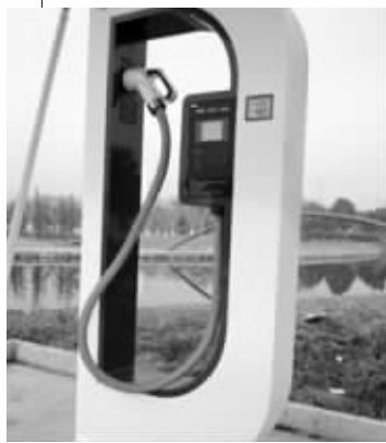
沪宁高速苏州阳澄湖服务区的电动汽车充电站已经建成投用 苏州供电公司
