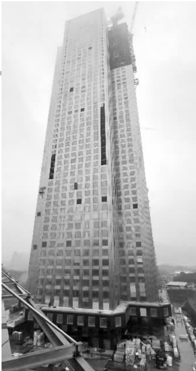
57层高楼施工现场 新华社记者 龙弘涛 摄
