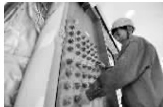
工人在内部安装钢结构
