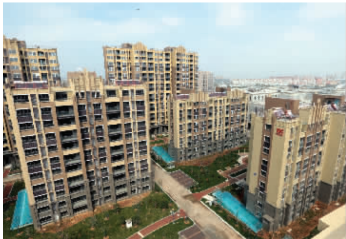
高淳中杭国际花园一期房子盖好了,却无法交付 现代快报记者 马晶晶 摄
