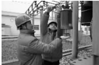
新春伊始,靖江市供电公司做好各项设备检修和消缺工作,为农民春耕生产提供用电保障。汪红清
