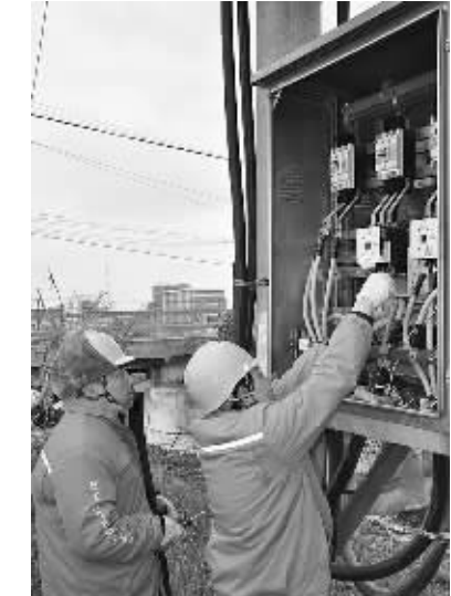
白马供电所为解决用户“卡脖子”问题,对辖区内的配电箱进行巡视检查,并利用春耕到来之前的空隙,将7台200KVA配电箱更换为400KVA配电箱。穆粉根 穆长杉
