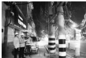
丰县供电公司组织5支队伍对城区用电负荷较重的台区开展测温工作,确保春节期间可靠供电。刘海滨
