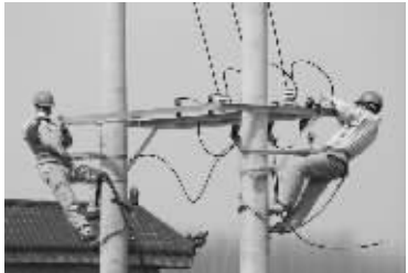
3月2日,睢宁供电公司加大农网改造力度,对农网低电压台片进行增容改造,为春耕用电保驾护航,图为施工人员安装变压器台架金具。朱友富 全勇
