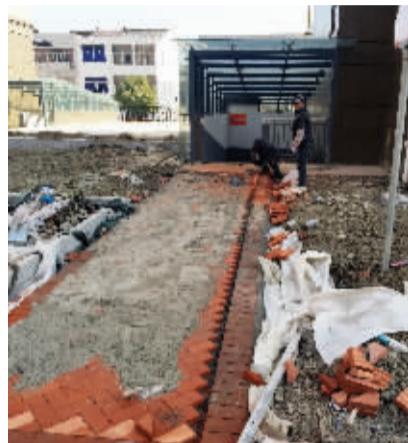
右图：里外城一期楼幢的建筑主体已经完工，但路面和绿化都还未建好
