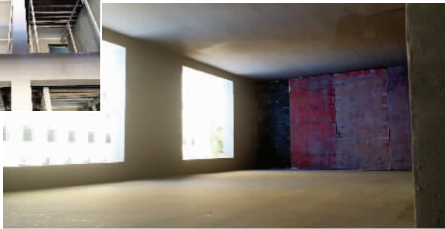
楼房的镂空结构经过违章施工,可凭空增加一个房间
