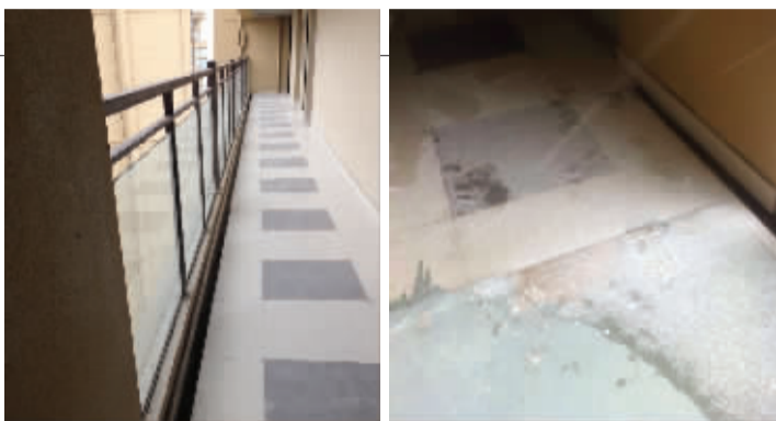
左图：金域华府5号楼采用外走廊半封闭设计，这给业主生活带来很多困扰 右图：上周下雪，外走廊地面有很多积雪，一不留神就会滑倒
