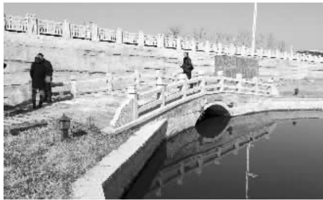
官塘桥古桥现状 林清智 摄
