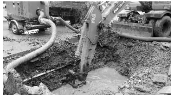
抢修爆裂的水管 现代快报记者 廖健伟 摄
