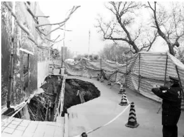
这是1月24日拍摄的北京德胜门内大街道路塌陷形成的大坑 新华社
