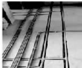
水电施工: 排放按国家标准, 强弱电保持分离。
