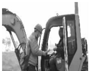
2014年11月份起,高邮市对甘垛、三垛、临泽等3个乡镇的22条小河流进行清淤,当地供电所对涉及治理的河道进行电力设施保护知识宣传,以防挖土机误碰电力线路。 林华鹏 徐天华
