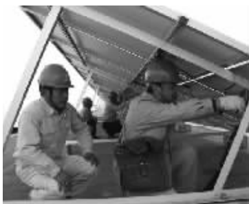
1月5日,供电人员来到宜陵镇,为该区最大的光伏发电用户——扬州永力电子集团维修损坏的发电装置,保证了装置的稳定高效运行。任飞
