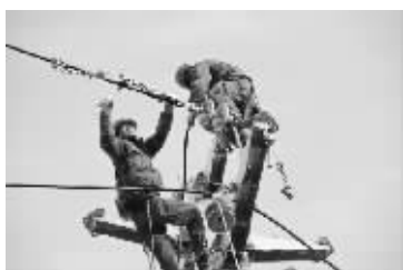
1月18日,睢宁供电公司员工放弃休息时间、克服恶劣天气、错峰施工,加紧农网改造工程施工进度,提高末端电压质量和居民户均容量,迎接即将到来的新春佳节。朱友富
