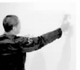
油漆施工：表面平整光滑无明显痕迹，阴阳角处理要直。
