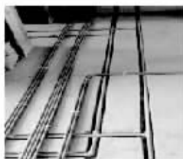
水电施工：排线按国家规范，强弱电保持距离。
