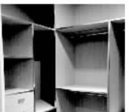
木工施工：环保生态板，基层平整，拼接整齐无明显接缝
