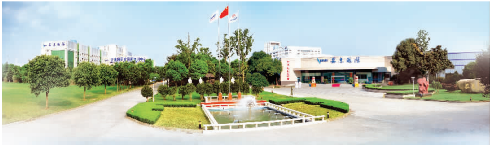
安惠生物科技有限公司园区(资料图片)
