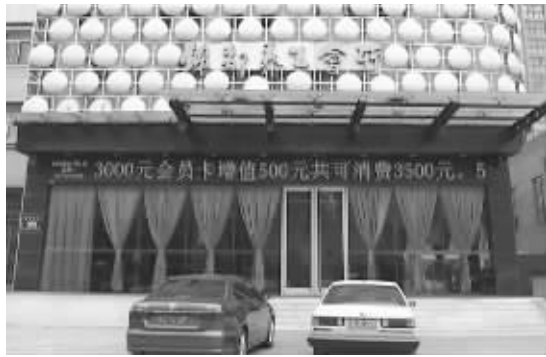
涉嫌盗用天然气的锦都养生会所
