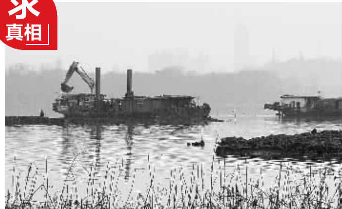
挖掘机正在施工 现代快报记者 徐洋 摄
