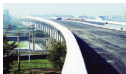
高芜高速桥梁比例占到60% 资料图片
