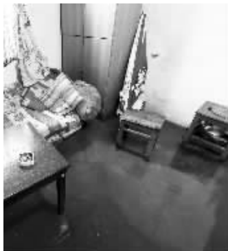
水管被损坏,水淹进张先生家中 现代快报记者 邱稚真 摄
