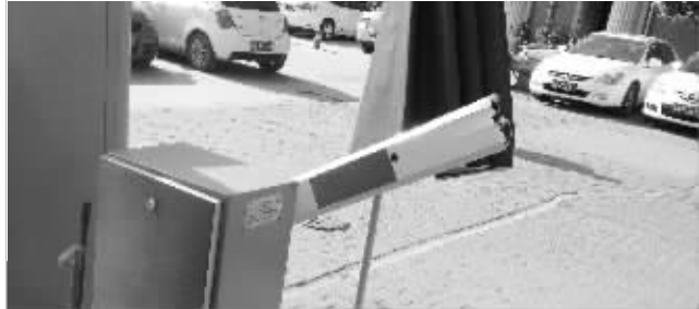
被损坏的栏杆
