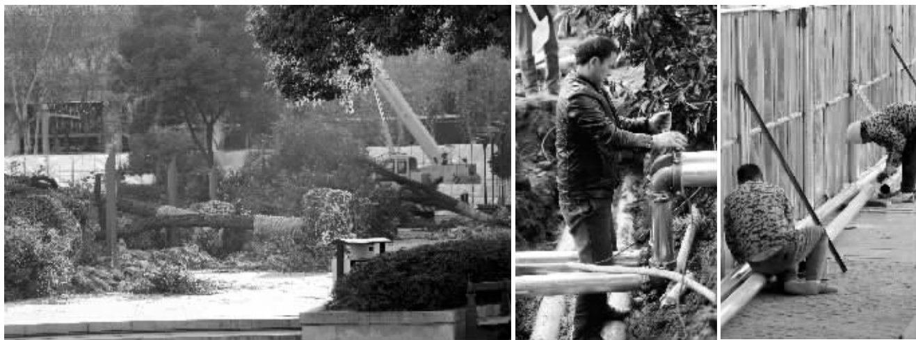
山西路市民广场已经开始施工 现代快报记者 赵杰 摄
