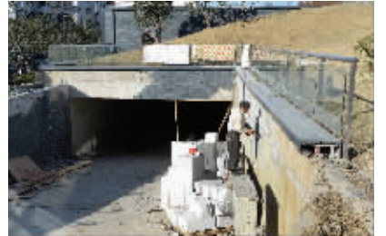
公园大门北侧的停车场即将建成 现代快报记者 赵杰 摄
