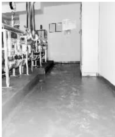
供水泵房地面新刷了漆
